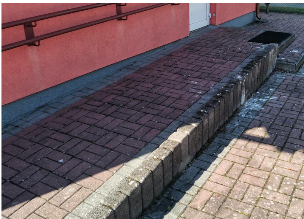
Fot.13 Brak balustrad przy pochylni
