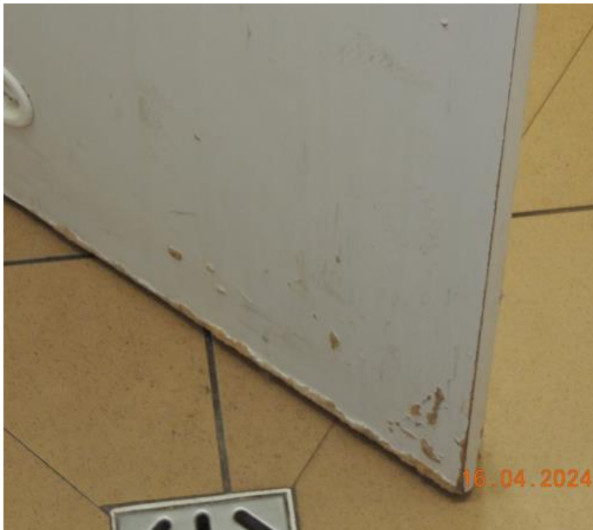
Fot.15 Uszkodzenia mechaniczne drzwi
