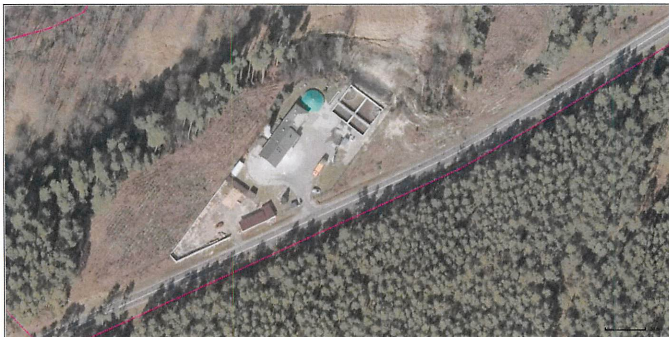
Rysunek 2 Oczyszczalnia ścieków w Józefowie
