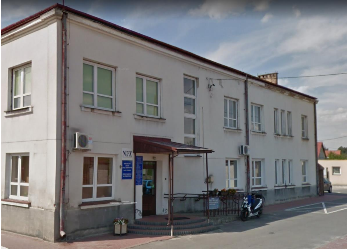
Ściana od strony wschodniej (wejście główne do budynku)
