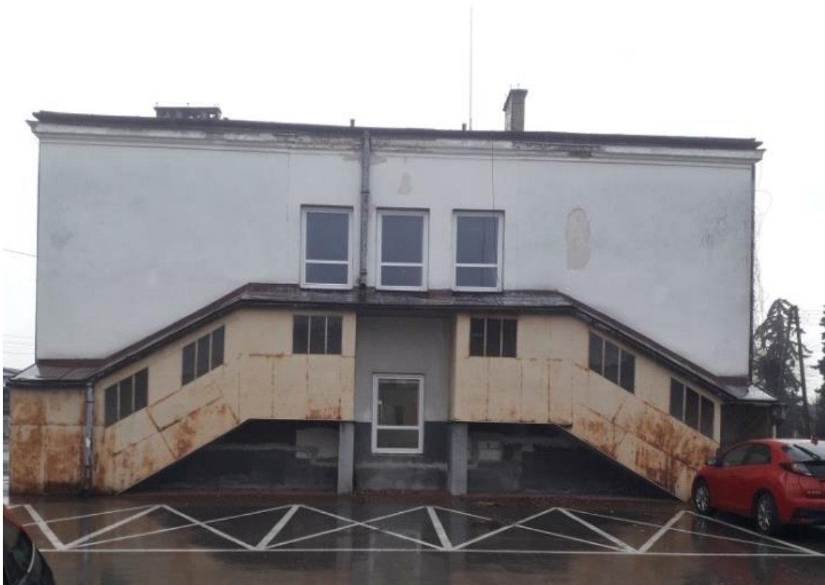
Strona północna budynku
