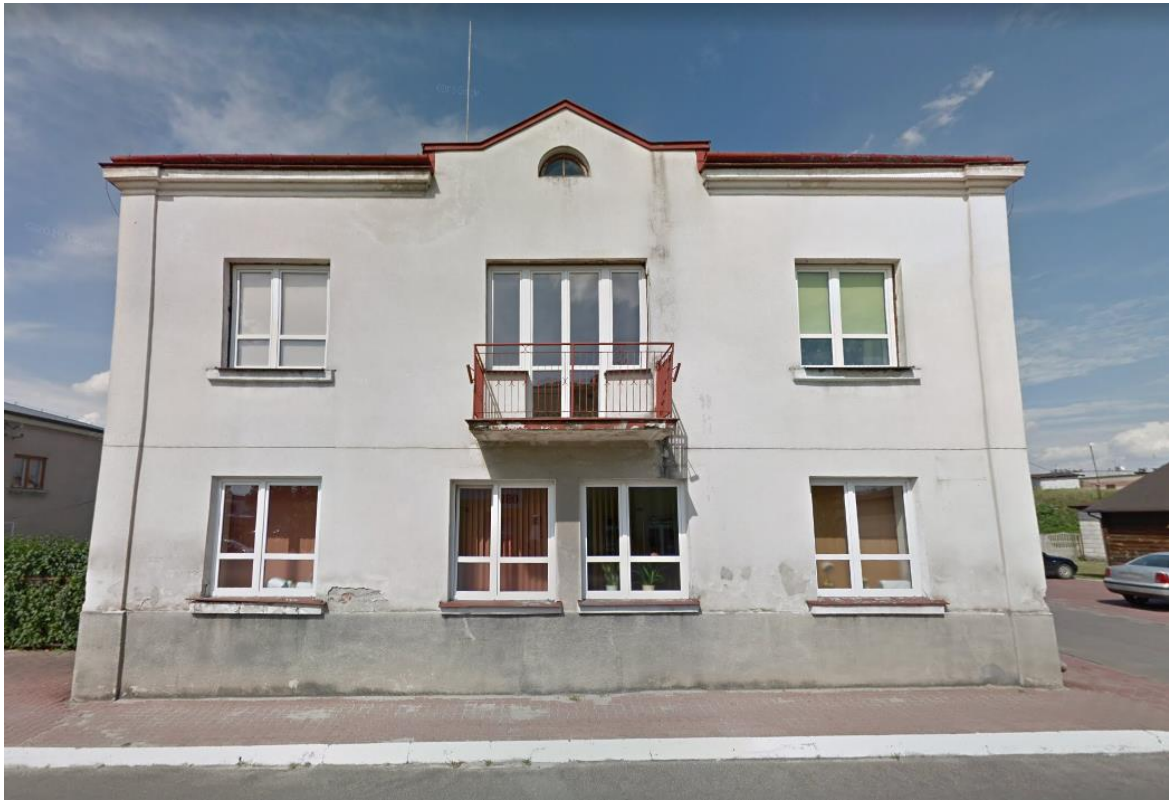
Ściana południowa od drogi wojewódzkiej nr 853
