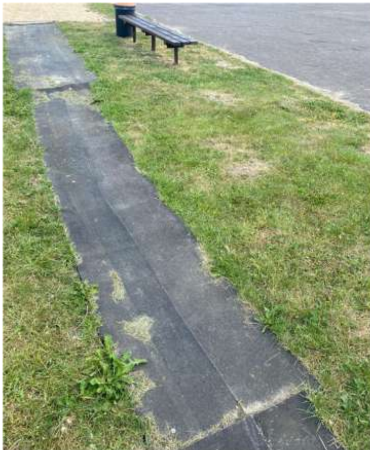
Fot.3 Prowizorycznie wykonana bieżnia do skoku w dal
