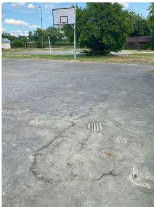
Fot.1 Nawierzchnia boiska do koszykówki.
